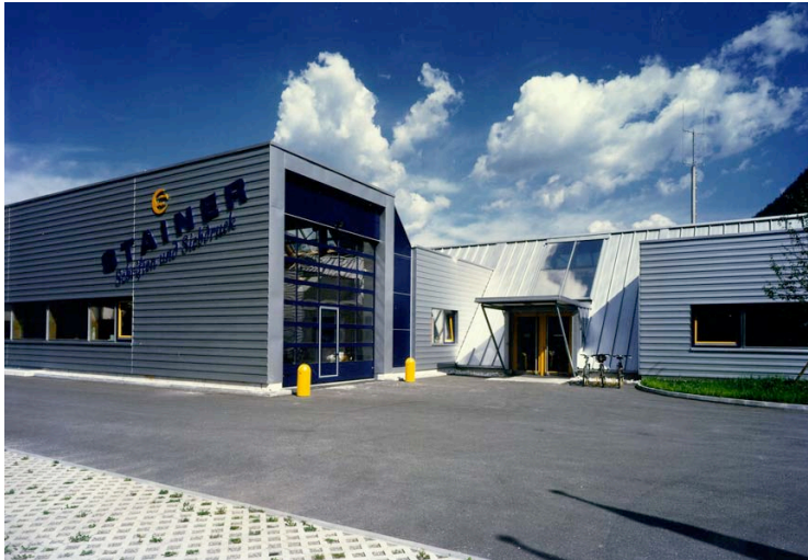
Außenansicht Zentrale Stainer Druck, St. Martin b. Lofer
