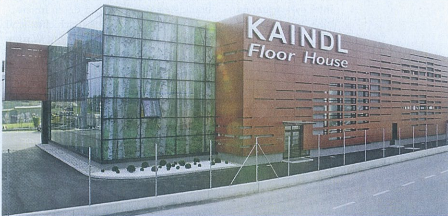
In Zusammenarbeit mit Eckelt Glas entstand diese Doppelglasfassade mit Innendruck in Salzburg
